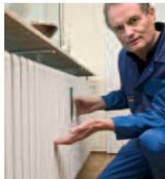
**10 Wärmeübergabe:** Die Inspektion der Heizkörperventile bzw. Raumregler wird mit einer Sichtprüfung in mindestens drei Räumen unterschiedlicher Größe oder Nutzung vorgenommen.
