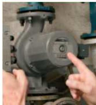
**8 Heizungspumpe:** Die Bewertung der Soll-Leistungsaufnahme erfolgt wenn keine Planungsdaten vorliegen, durch Abschätzungen mit Hilfe eines grafischen Verfahrens.
