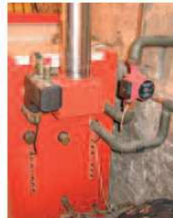
**4 Brennwertnutzung:** Durch eine Sichtprüfung (z. B. anhand von Typenschild, Herstellerunterlagen, Kondensatanfall) wird beurteilt, ob sich der Wärmeerzeuger zur Brennwertnutzung eignet. Ist das nicht der Fall, werden entsprechende Punkte vergeben.
