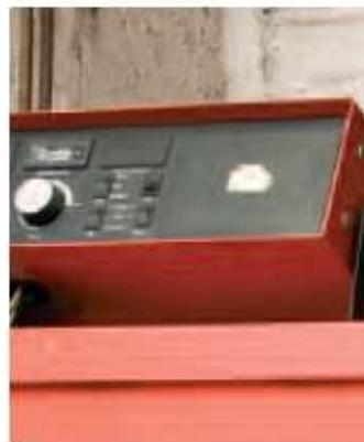
**6 Regelung:** Auf Basis einer Sichtprüfung werden für die vorgefundene Kesselregelung (z. B. ohne Regelung, raumgeführte oder außentemperaturgeführte Regeleinrichtung) abgestufte Punktzahlen vergeben.
