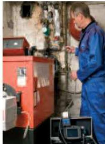
**3 Ventilationsverluste:** Durch gleichzeitige Ermittlung von Strömungsgeschwindigkeit und Temperatur im Restkernstrom der Abgasabführung wird der Wärmeverlust im Abgassystem des Heizkessels 30 Sekunden nach Brennerschluss bestimmt. Über eine vorgegebene Formel kann der Ventilationsverlust aus Strömungsgeschwindigkeit und Temperatur im Abgasstutzen errechnet und mit Hilfe einer Grafik in Bewertungspunkte umgerechnet werden.
